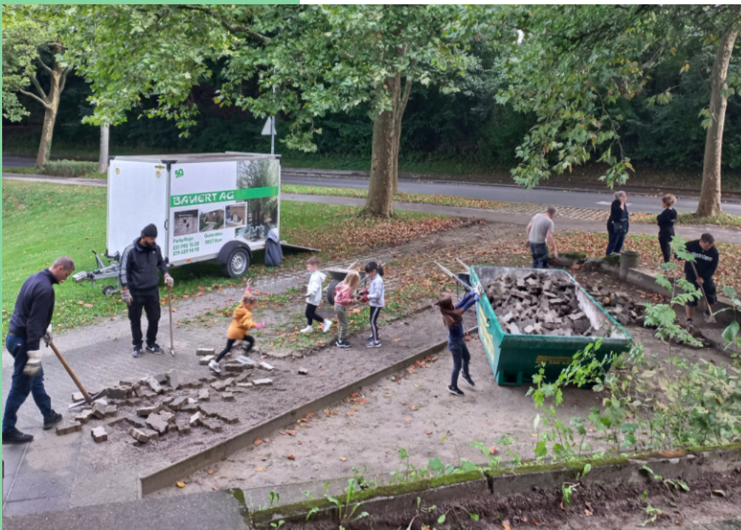
Umbauarbeiten am Spielplatz - die Quartierbewohner*innen halfen tatkräftig mit.
