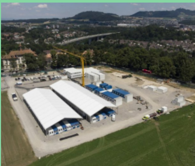
Container-Dorf als temporärer Unterkunft im Viererfeld Quelle: https://www.srf.ch/static/cms/images/960w/5e4705.jpg
